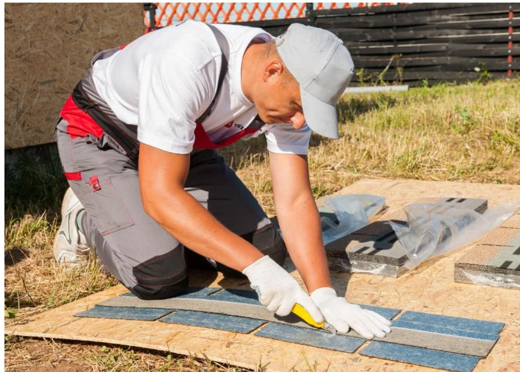
*У фасадных плиток, используемых для устройства первого ряда, отрезают «лепестки».*
