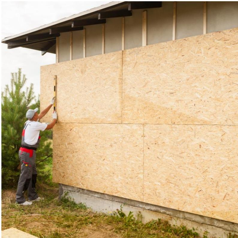
*Для исключения температурных расширений не забудьте сформировать зазоры между плитами шириной 2-3 мм.*
